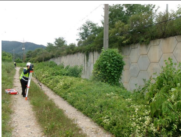
광파기를 이용한 측량 작업
